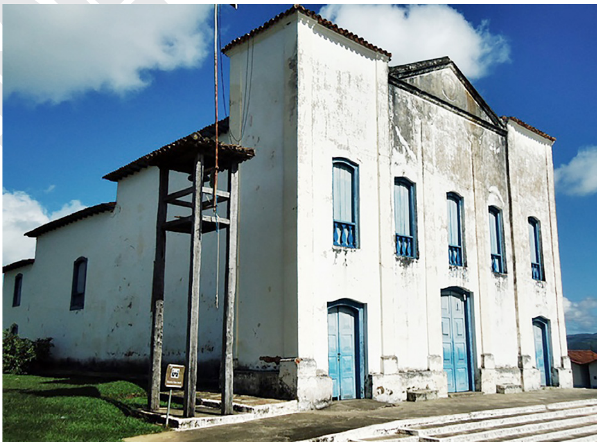
Figura 5 - Vista atual da Igreja São José, de Mossâmedes (GO) Fonte: Acervo da autora
